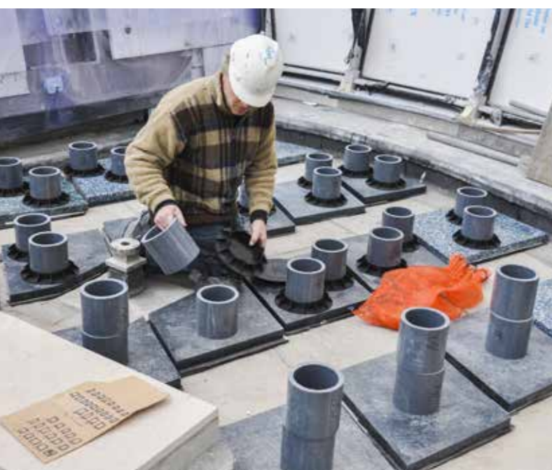
Insertion du tube DNS® Heavy découpés
