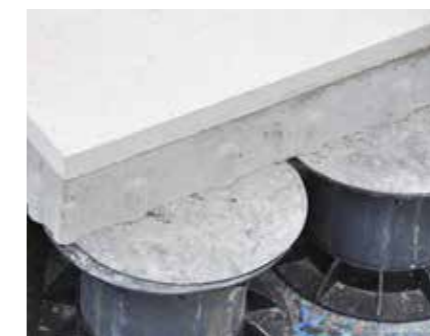
Les dalles sur le disque support et de calage en EPDM
