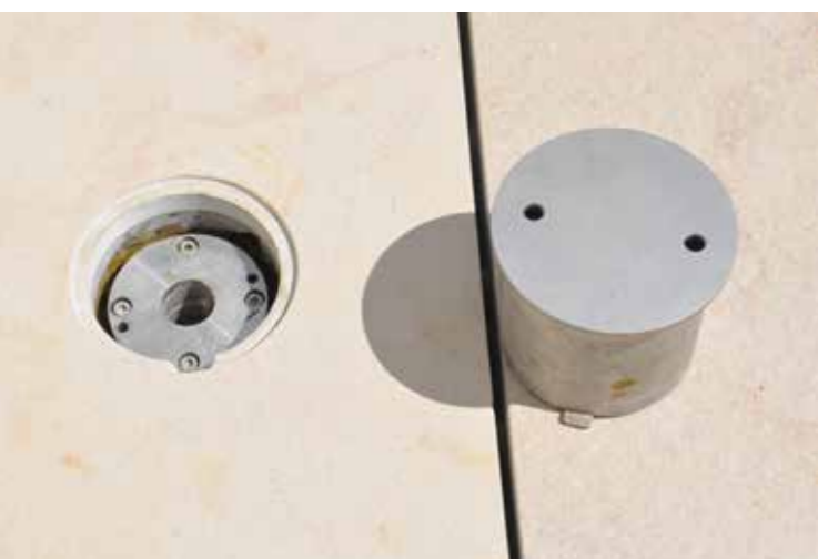
Détail d'un plot d'ancrage
