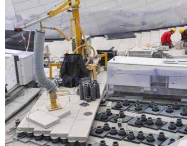
Mise en œuvre des dalles sur le système de support DNS® Heavy
