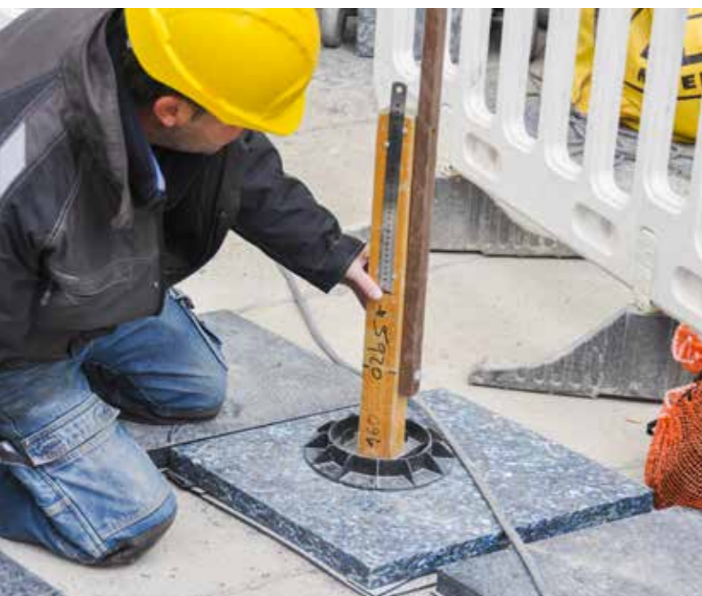
Balise utilisée pour déterminer la hauteur souhaitée
