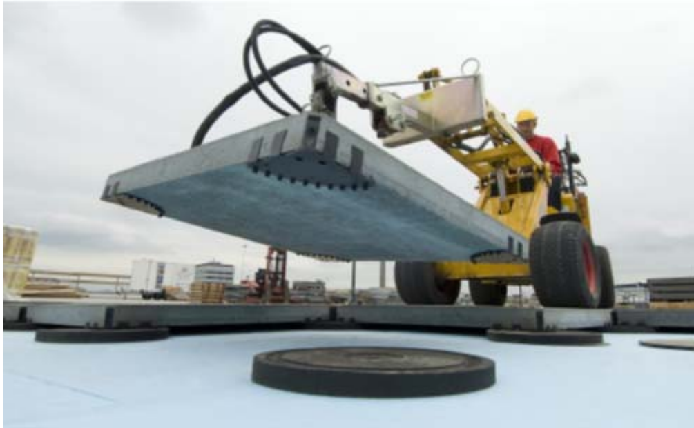
Figure 5 – Exemple d'entretien avec une machine de levage autoportée
